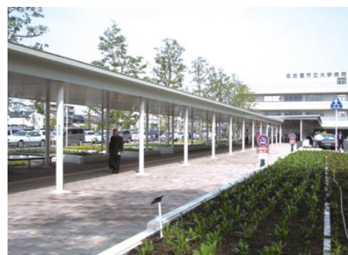
附属病院前のアプローチの工事が終わり、緑あふれるスペースになりました。
